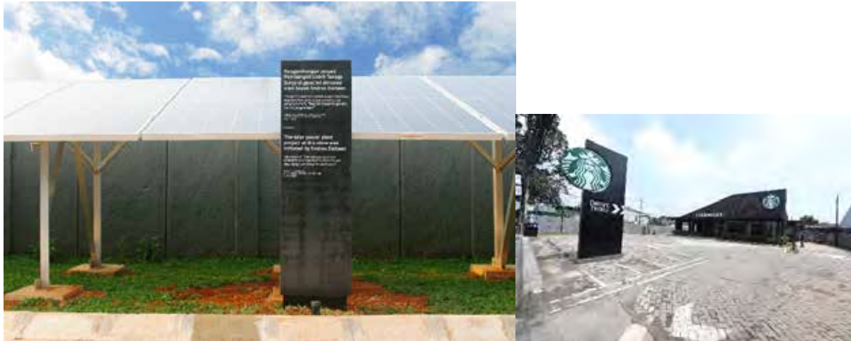
Pemanfaatan Panel Surya di gerai Starbucks
